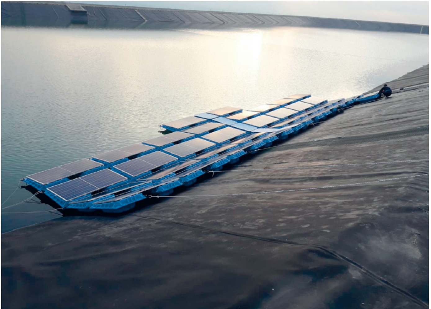
Figura 1. Vista de les plaques flotants durant la instal·lació. Font: ASG.
